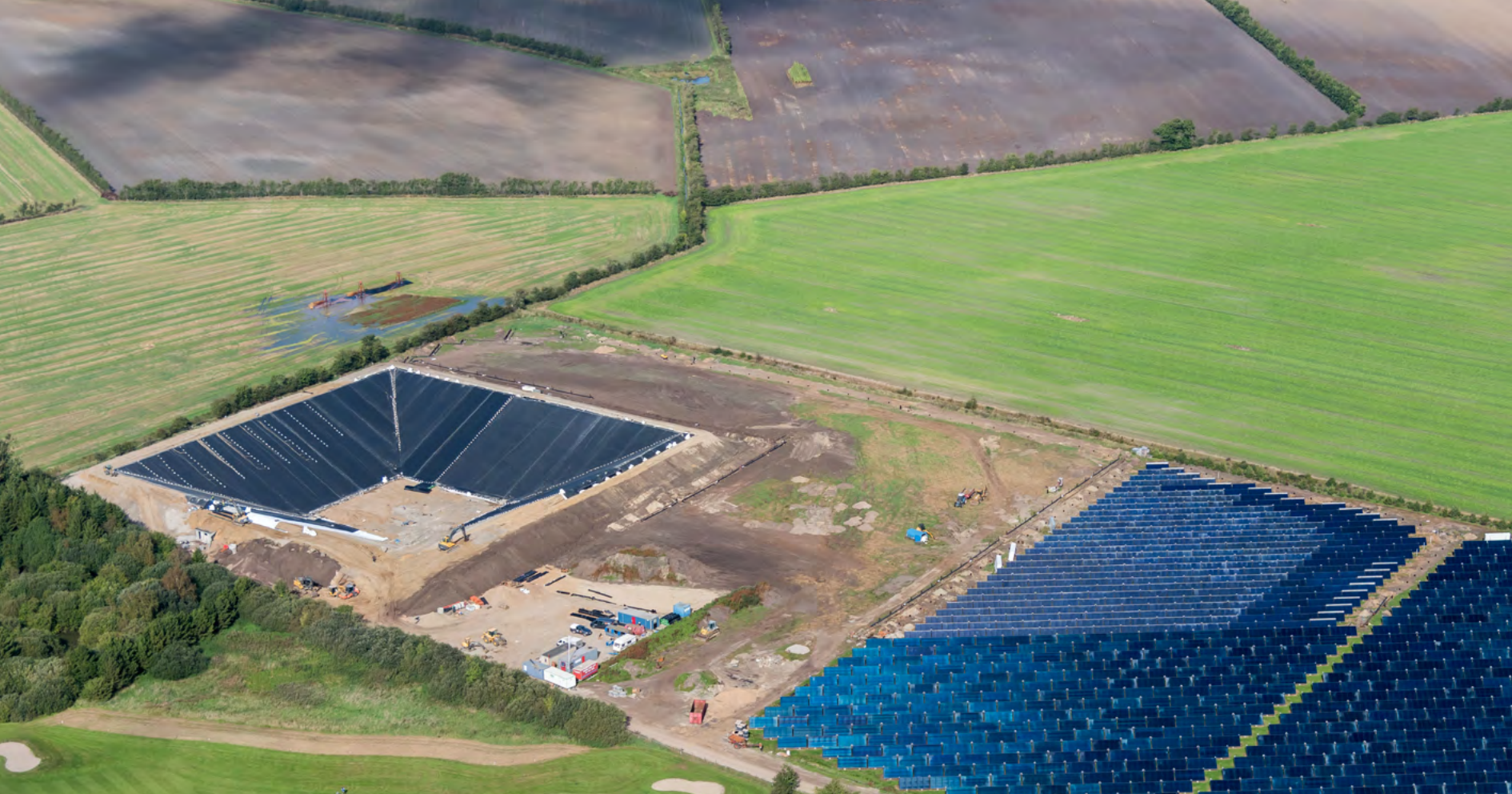
I Danmark finns flera stora säsongslager som lagrar värme från sommar till vinter, teknik som ännu inte introducerats i Sverige. Bilden: Groplager under uppbyggnad i den danska staden Toftlund. Foto: Jesper Larsen.
