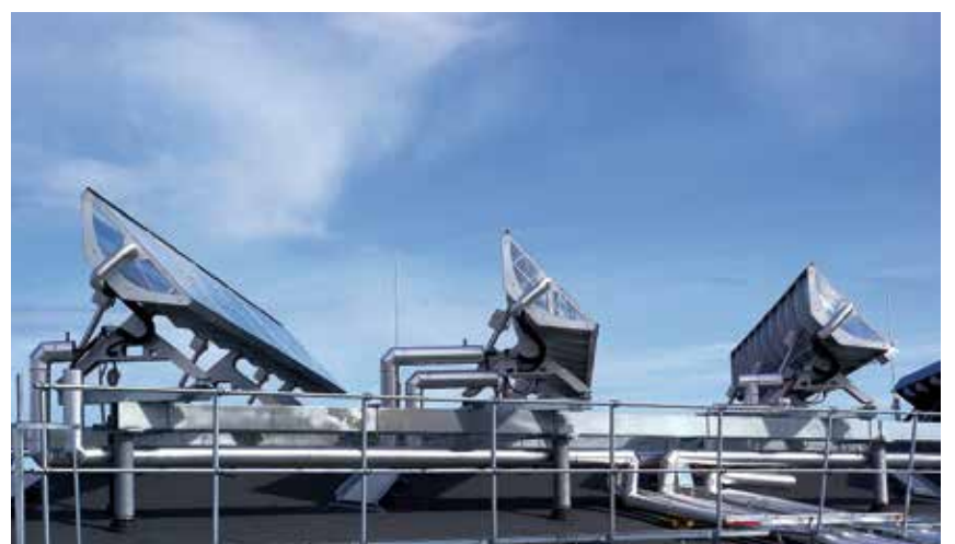
• Närvården i Härnösand har Absolicons solfångare på taket. Installationen driver med solkyla luftkonditionering i byggnaden.
