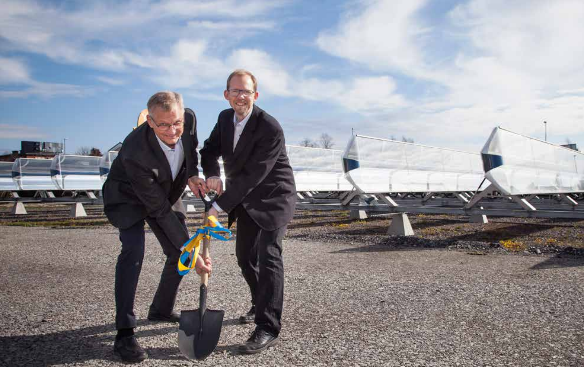
• Ingemar Forzelius, vd på Hemab och Joakim Byström, vd på Absolicon tar första spadtaget för den nya anläggningen för solånga.
