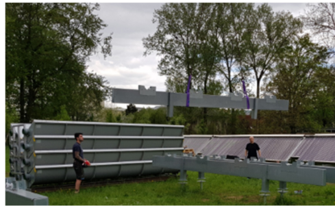
Installation i fjärrvärmenätet i Graz
