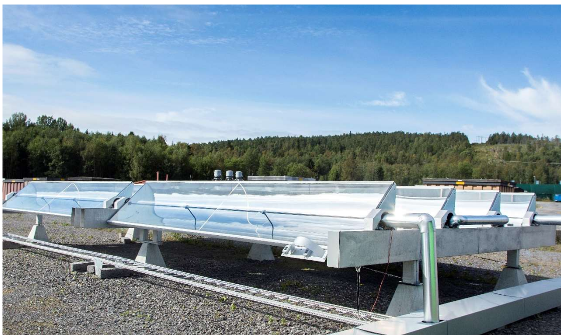
Absolicons pilotinstallation för solånga på Energiparken i Härnösand.
