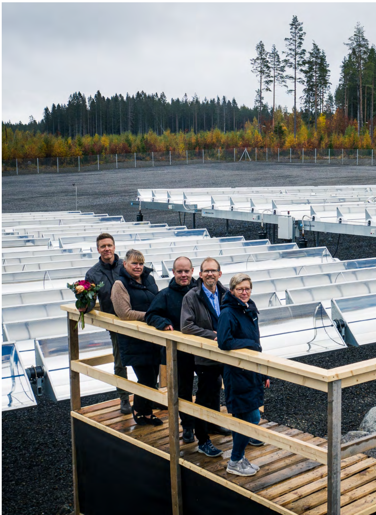
Högsletten 2023 Solar Thermal Park driftsattes i september 2021. Parken består än så länge av ca 1000 m 2 solfångare samt en teknikbyggnad för besök och integration mot fjärrvärmenätet. Hela parken ska stå färdig 2023. Foto: Martin Sundqvist
