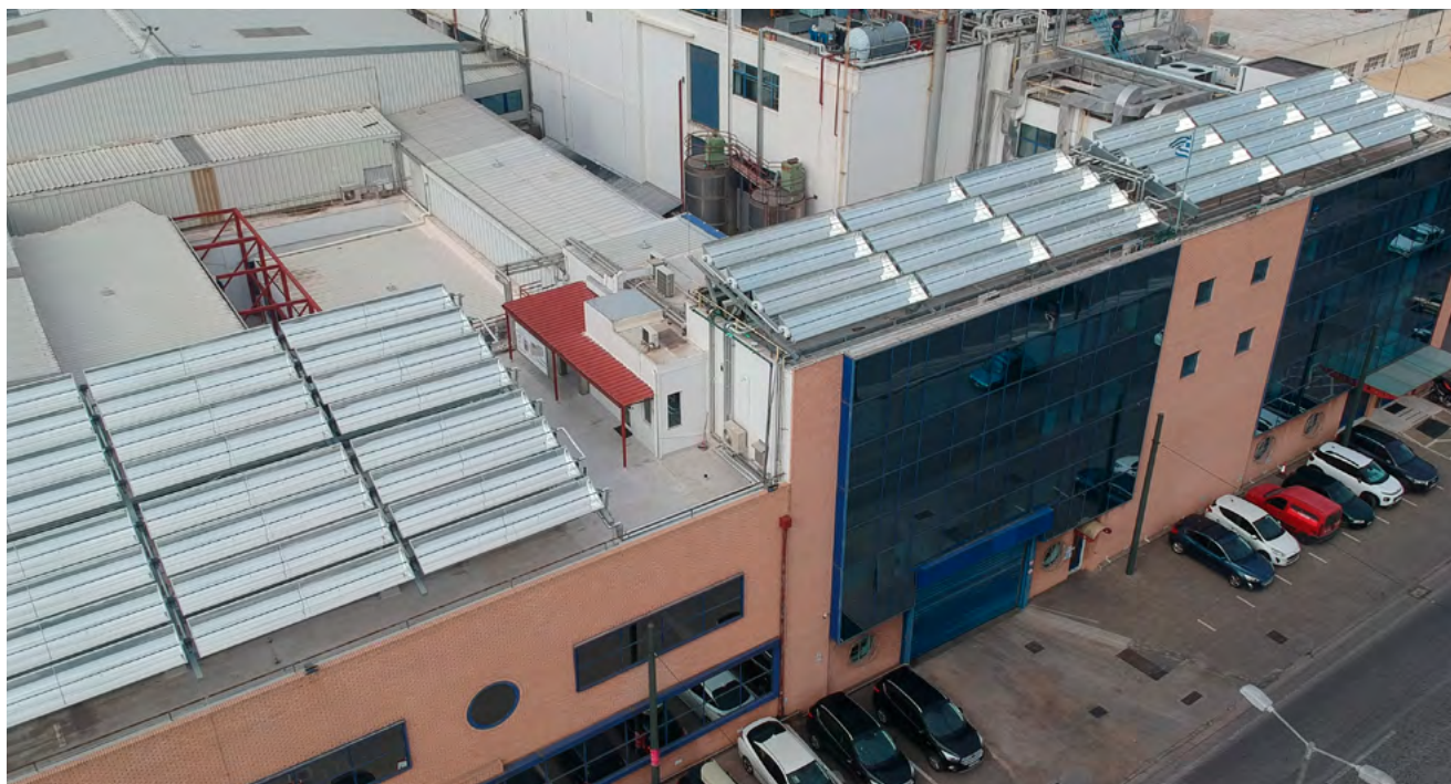
Installationen på Colgate-Palmolives fabrik i centrala Aten syns på långt håll. Hettan som genereras i solfångarna används för att tillverka hushållskemikalier. Foto: Modolar
