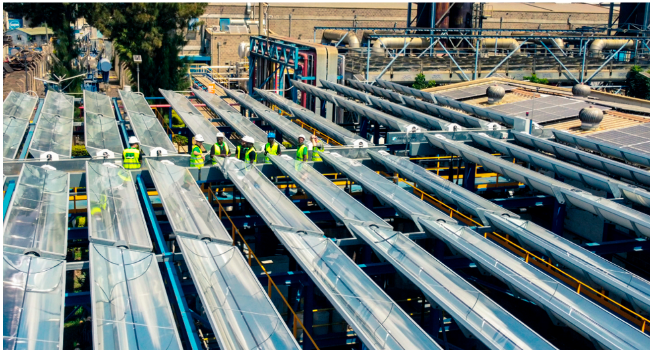
Solvärmefältet är upphöjt 5,5 m i luften, vilket maximerar solbestrålningen på installationen. Foto: Elvis Momanyi Masare
