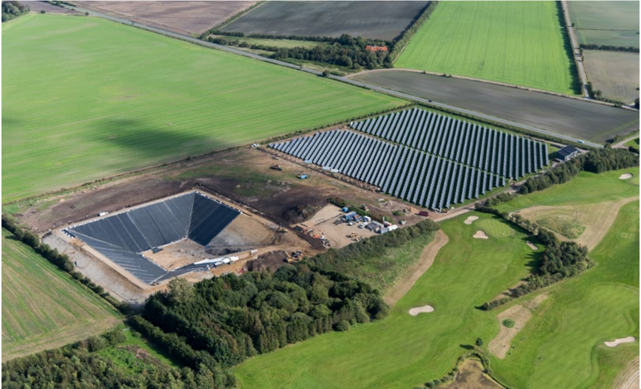
Groplager under uppbyggnad i Dronninglund, Danmark. Foto: Jesper Larsen
