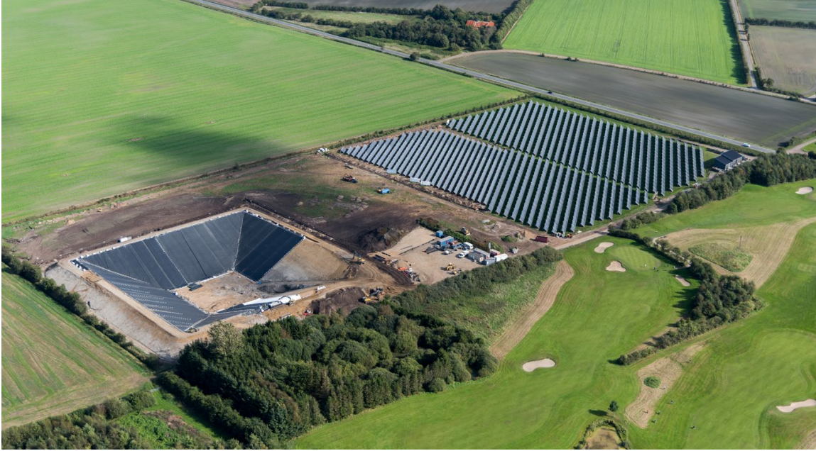
Groplager under konstruktion i danska Toftlund med tillhörande solvärmefält som färdigställt kom att täcka 50% av stadens värmebehov.
